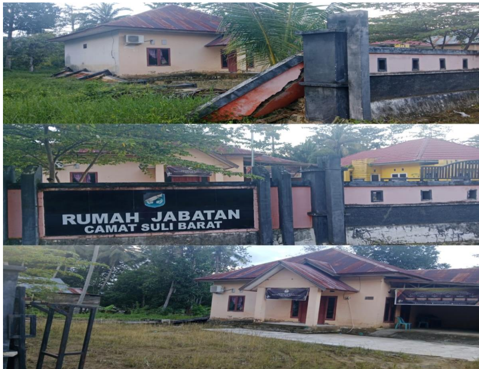
Gambat 4.6 Kondisi Pagar Rumah Jabatan Camat Suli Barat
