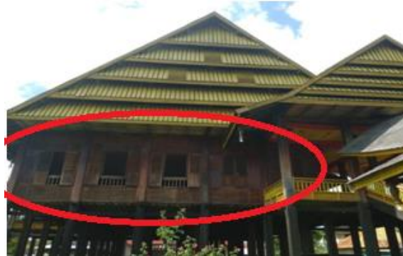
Gambar 4.9 Balok pada badan rumah ( ale lino )
