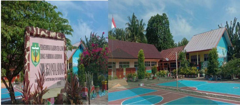
Gambar 1. Foto pada saat melakukan observasi di SDN 353 Patalabunga yang diambil pada hari Selasa 5 Oktober 2021, pukul 09.45 WITA.
