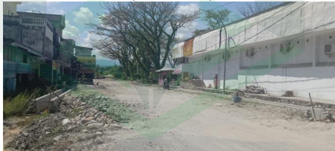
Proses pembangunan jalan dan Drainase (2 Juni 2022)
