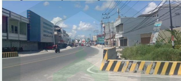
Jalan trans Sulawesi yang terdampak banjir bandang sudah bisa di lalui (2 Juni 2022)
