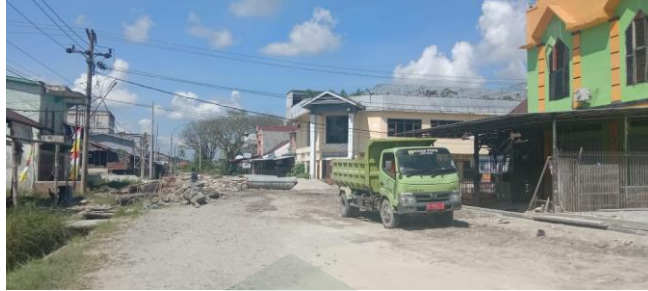
Proses pemulihan jalan dan plat duiker (2 Juni 2022)
