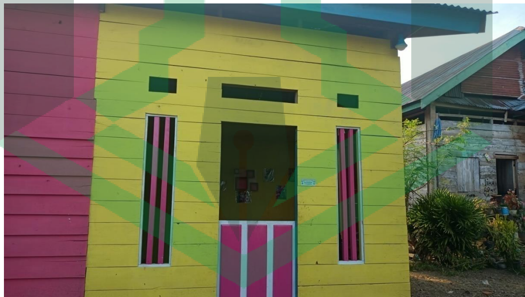
Rumah Ibu Suriati penerima manfaat Program Bedah Rumah yang telah rampung 100%
