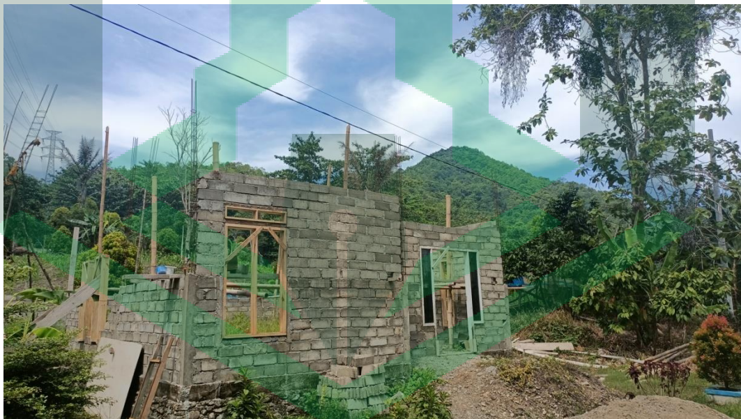
Foto rumah ibu Nurafni Penerima Program Bedah Rumah yang Sementara dalam Proses Pembagunan
