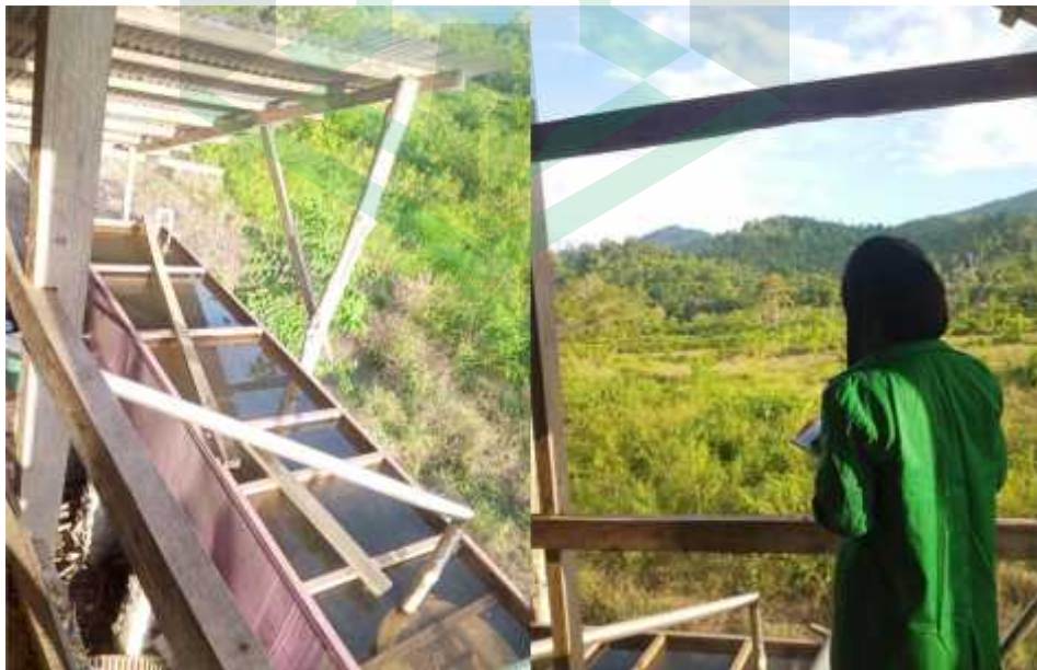
Tempat penampungan air penyulingan minyak
