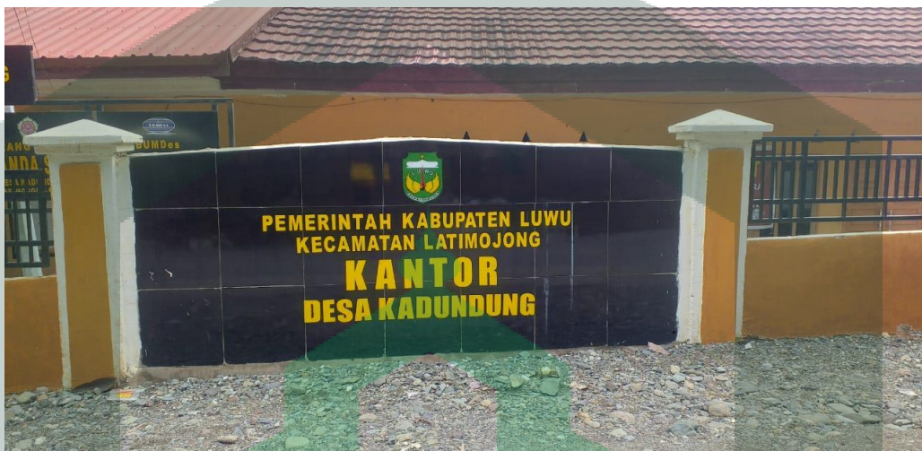
Gambar 4.1 Kantor Desa Kadundung
