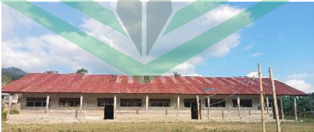
Kondisi Bangunan Sekolah
