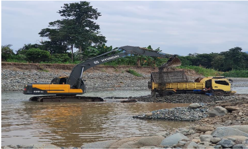
Gambar 4.2 Proses Pemuatan Pasir di Sungai Noling
