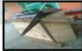
2. Setelah tiap balok kerangka telah dipotong sesuai ukuran, mulailah untuk menyatukan tiap balok membentuk kerangka.
