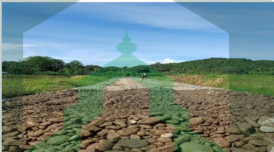
Dok: Pembentukan/pembangunan/Pengerasan Jalan tani
