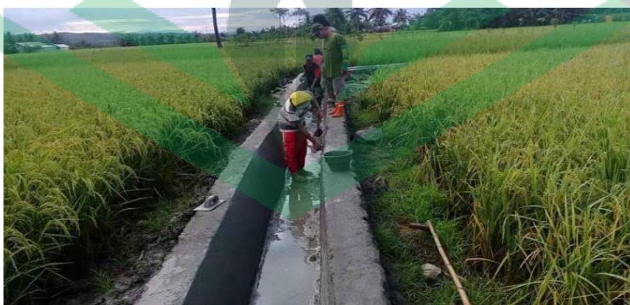
Dok: Pembangunan Saluran Irigasi Tersier
