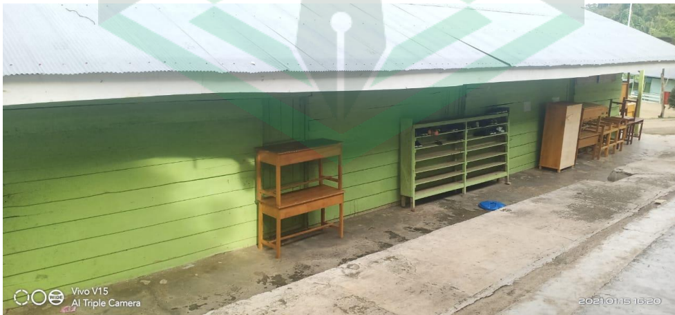
Gedung ALIGARH ( Rayon Santri Putra Lama )
