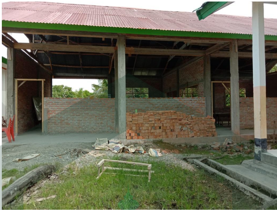
(Penambahan Ruang Kelas)
