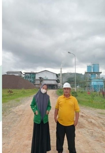
Tampak depan Pabrik PT . Kasmar Matano Persada
