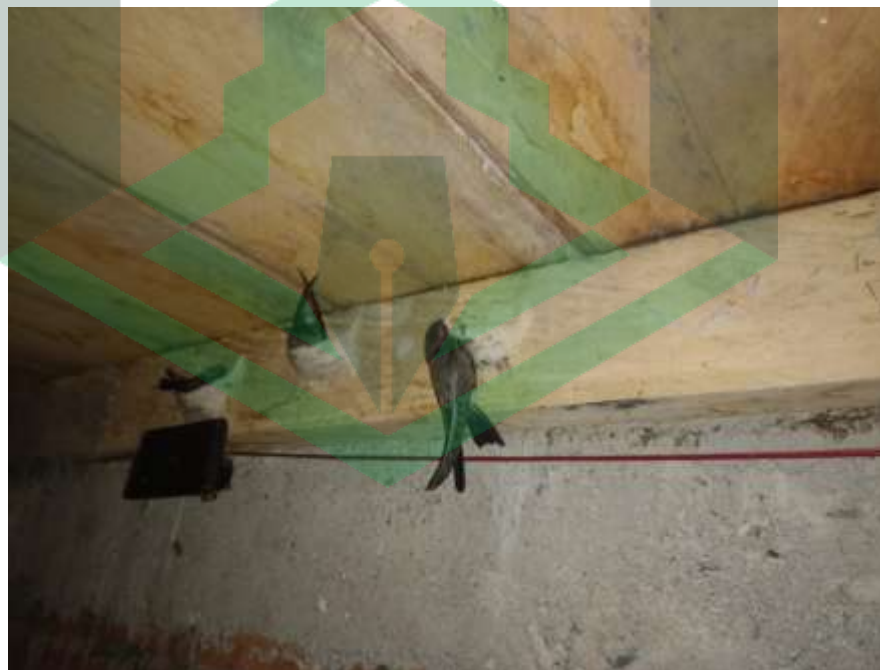
Kondisi dalam Gedung Walet
