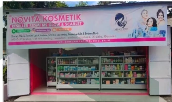
Gambar 4.2 Toko Setelah Renovasi Pertama
