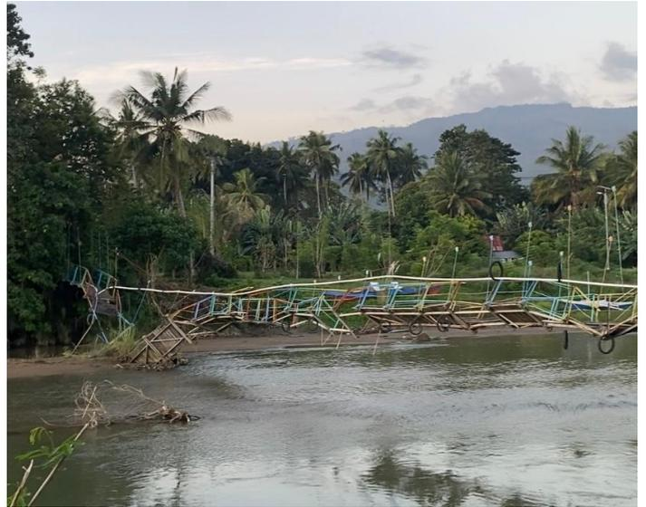
Gambar 1.10 Kondisi Jembatan Gantung di Desa Pitulua yang mengalami kerusakan
